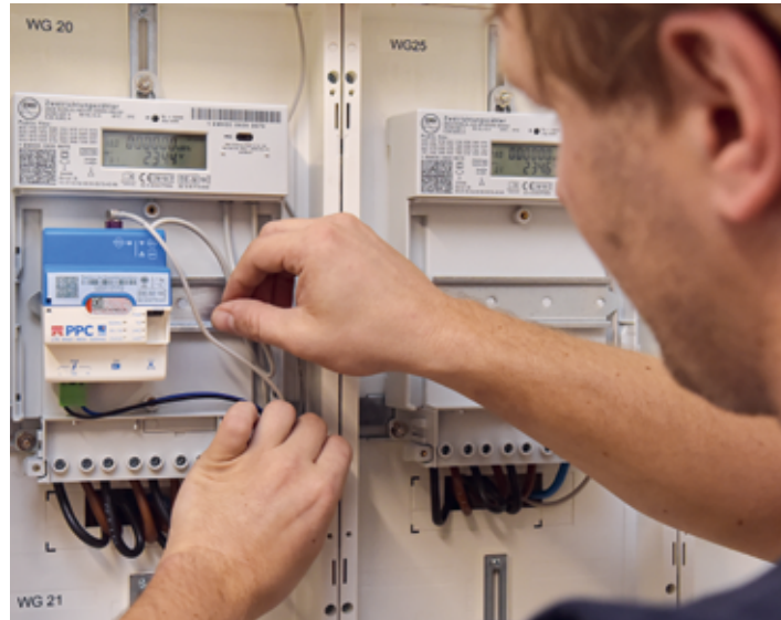
Smart Meter Gateway: Installation eines Gateways in der Wohnanlage in Hermsdorf. Foto: Stadtwerke Jena/Jürgen Scheere
