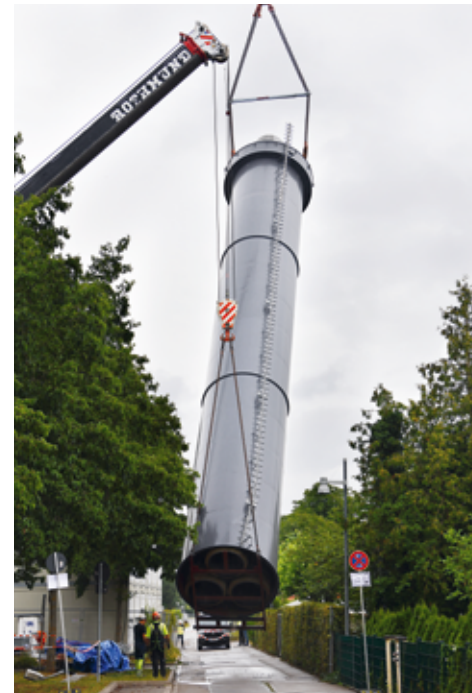
Installation des Schornsteins in Pforzheim für die Kraft-Wärme-Kopplungsanlage.
